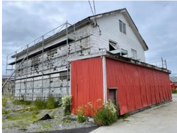
I denne bygningen ved «Sy`n» var det Samvirkelag fra 1947 til 1985. Foto: Ann Kristin Klausen.
