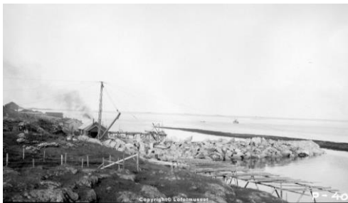
Bygging av molo på Skjærvær. Arkiv: Lofotmuseet.
