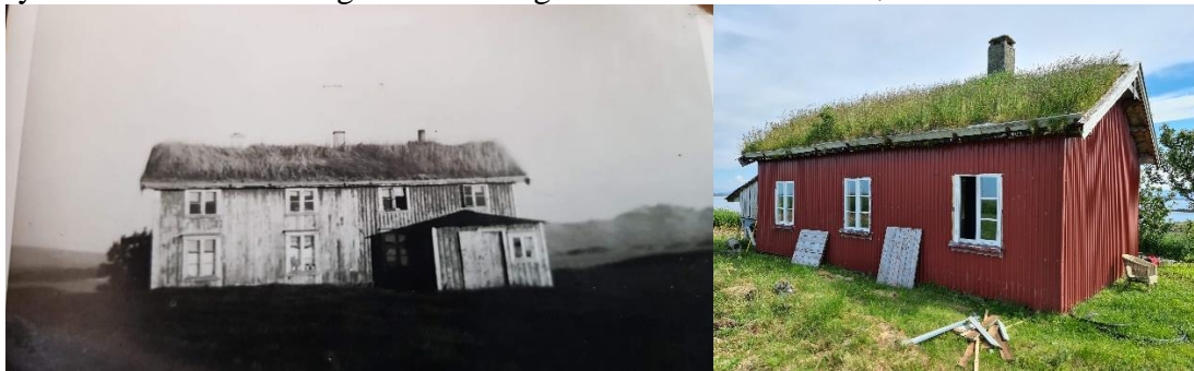
Lisøya før og etter renovering. Foto til høyre: Ove Cederstrøm.
